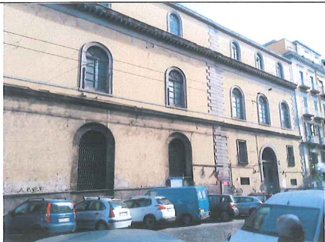
Prospetto Sud, via Cesare Rossaroll
