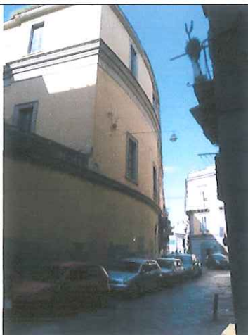
Prospetto Nord, via Fossi a Pontenuovo
