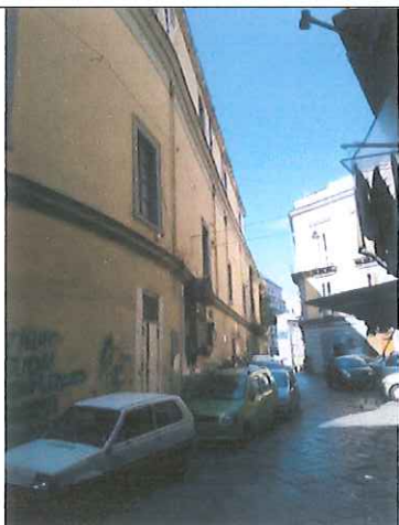
Prospetto Nord, via Fossi a Pontenuovo
