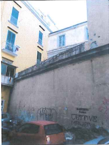
Prospetto Nord, via Fossi a Pontenuovo
