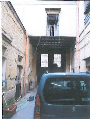
Androne visto dal cortile interno
