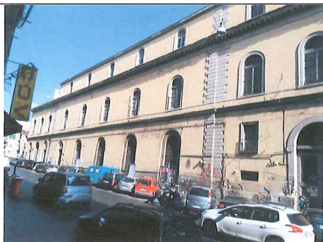
Prospetto Sud, via Cesare Rossaroll, civ. 130-134
