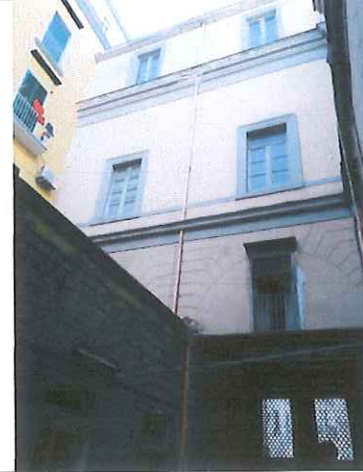
Prospetto Nord su cortile interno
