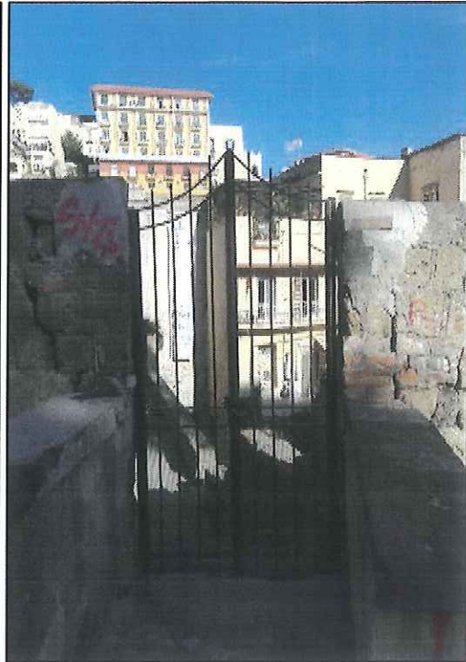
Ingresso al Piano Terra dallo Scalone di Mmontesanto
