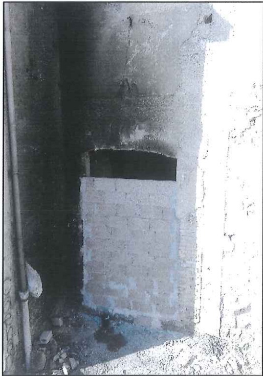
Cancello di ingresso con catena saldata ed accesso tamponato.
