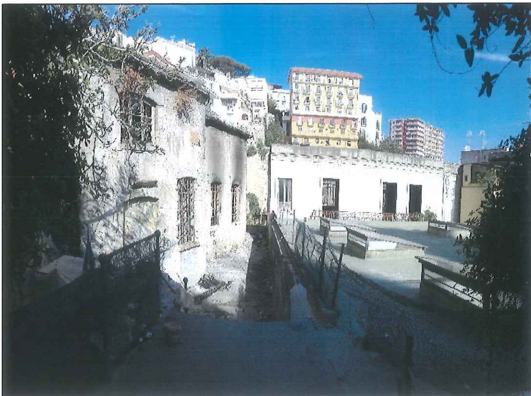
Vista del fronte ovest dall'ingresso su via Scalone di Montesanto.
