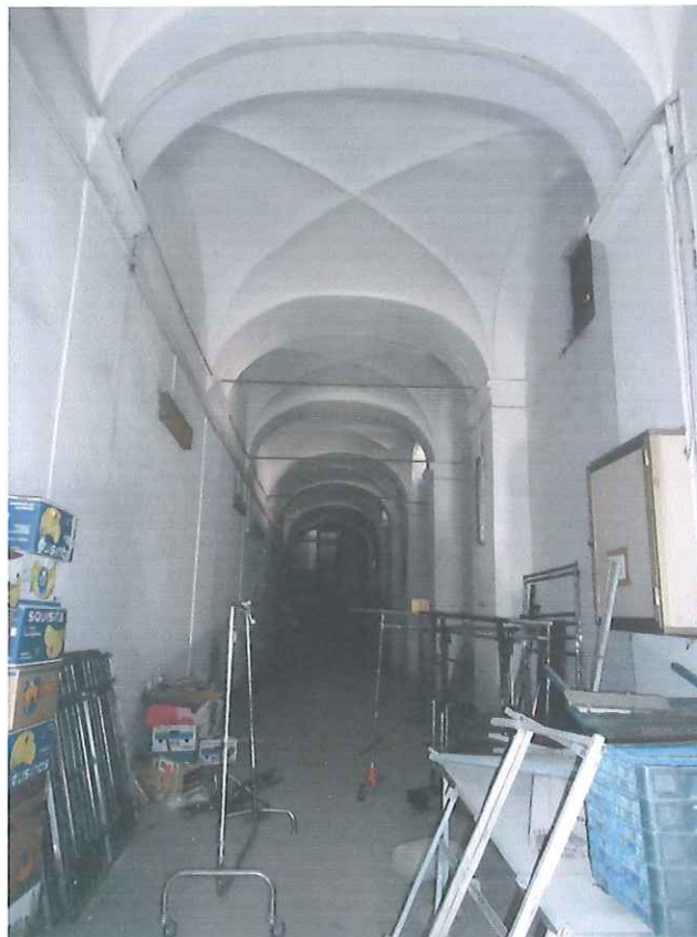
Foto n°20 - Vista della galleria
