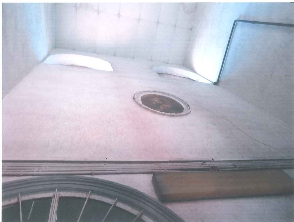
Foto n°23 - Le luci del vano scala sul terrazzo del secondo piano
