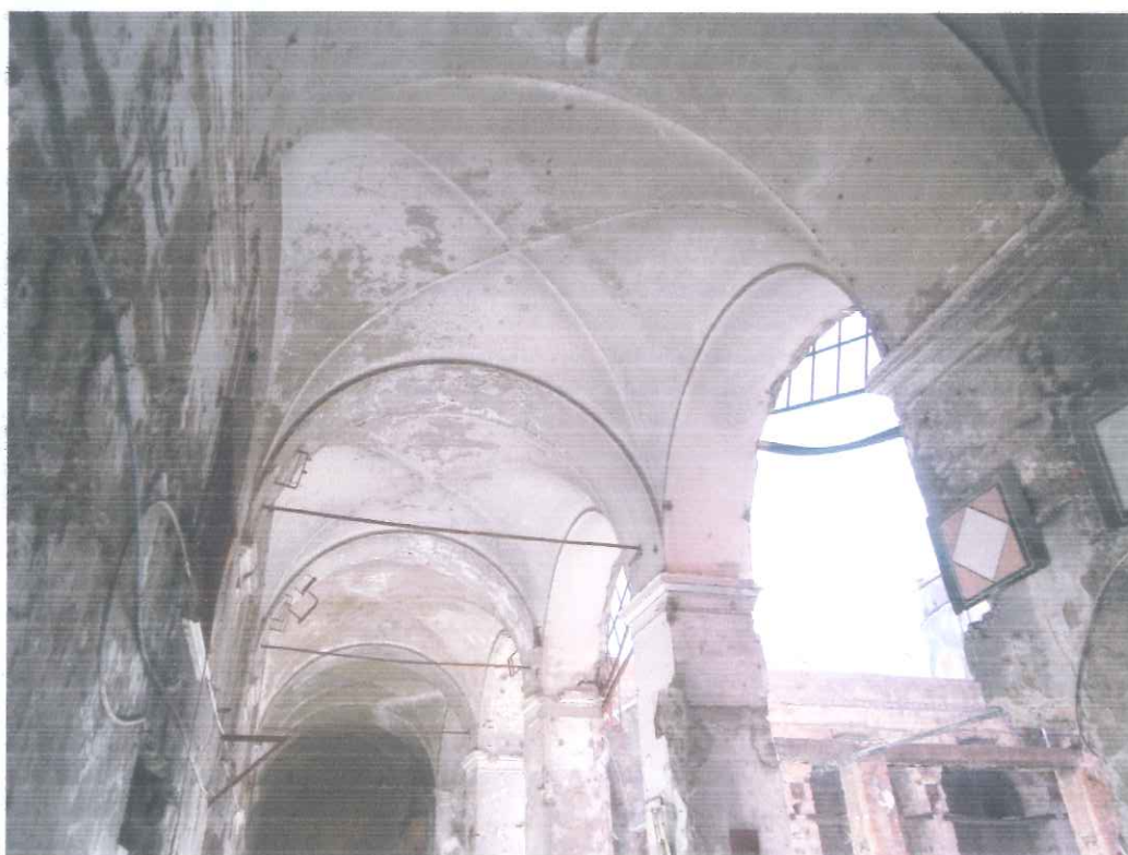
Foto n°6 - Il portico principale, particolare delle volte a crociera
