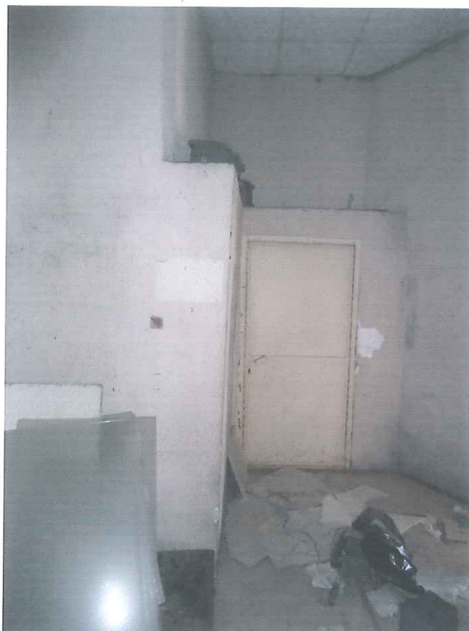
Foto n°25 - La porta della scala che conduce al secondo piano
