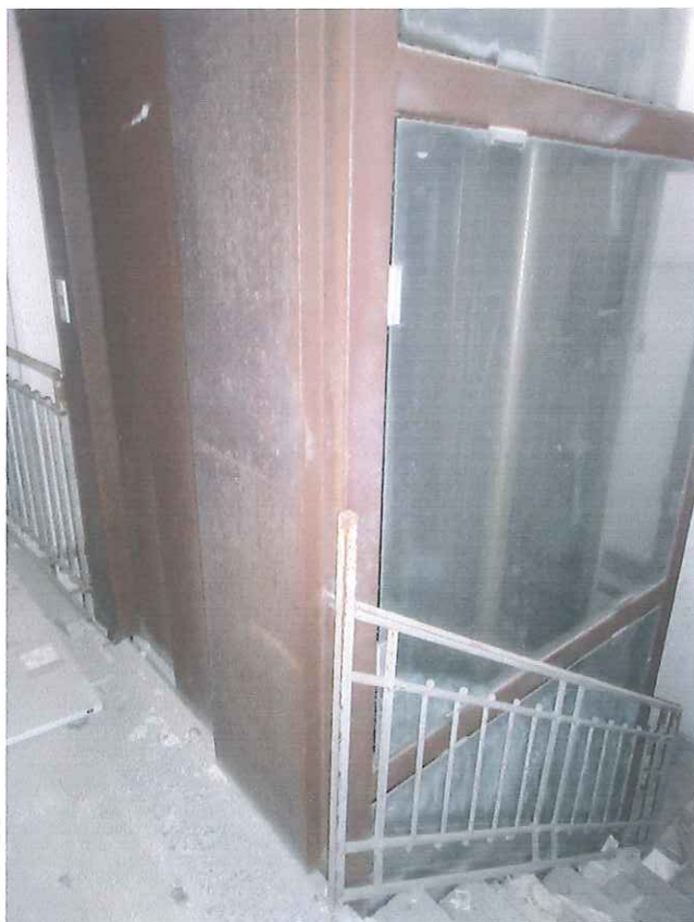
Foto n°22 - Il pianerottolo di smonto del primo piano e l'ascensore
