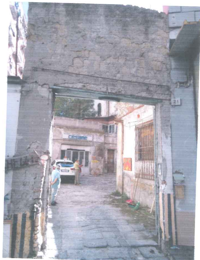
Foto n°2 - L'ingresso principale da via Nicola Galdo
