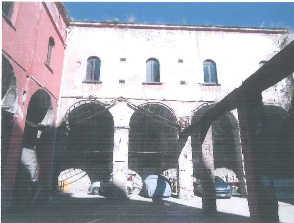
Foto n°10 - Vista del corpo A dal cortile principale. Sulle arcate le strutture di ancoraggio della copertura del cortile oggi non più esistente
