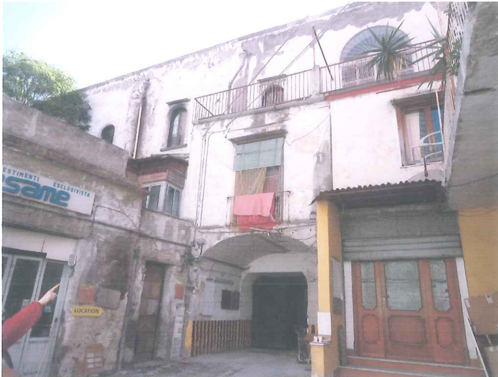
Foto n°3 - Vista dal cortile di ingresso
