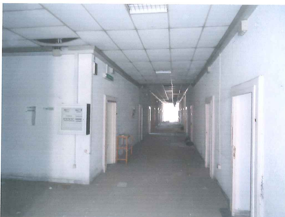
Foto n°26 - il corridoio Sud-Ovest
