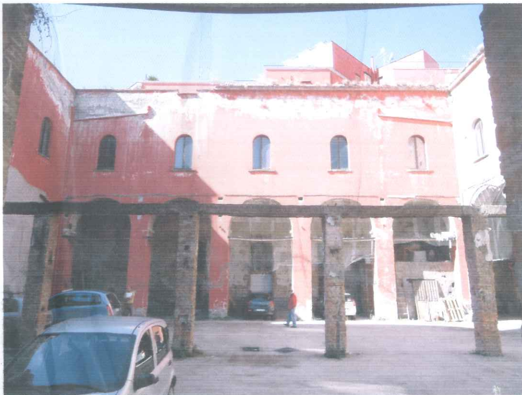
Foto n°8 - Vista del corpo A dal cortile principale
