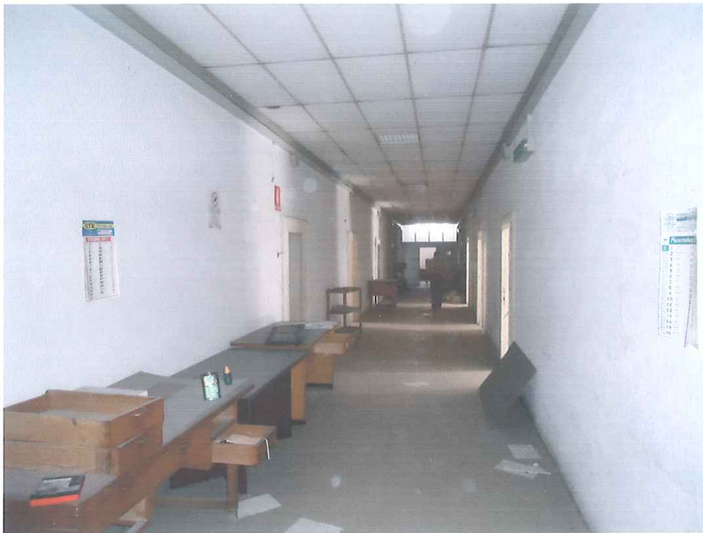
Foto n°31 - Il corridoio Nord-Ovest
