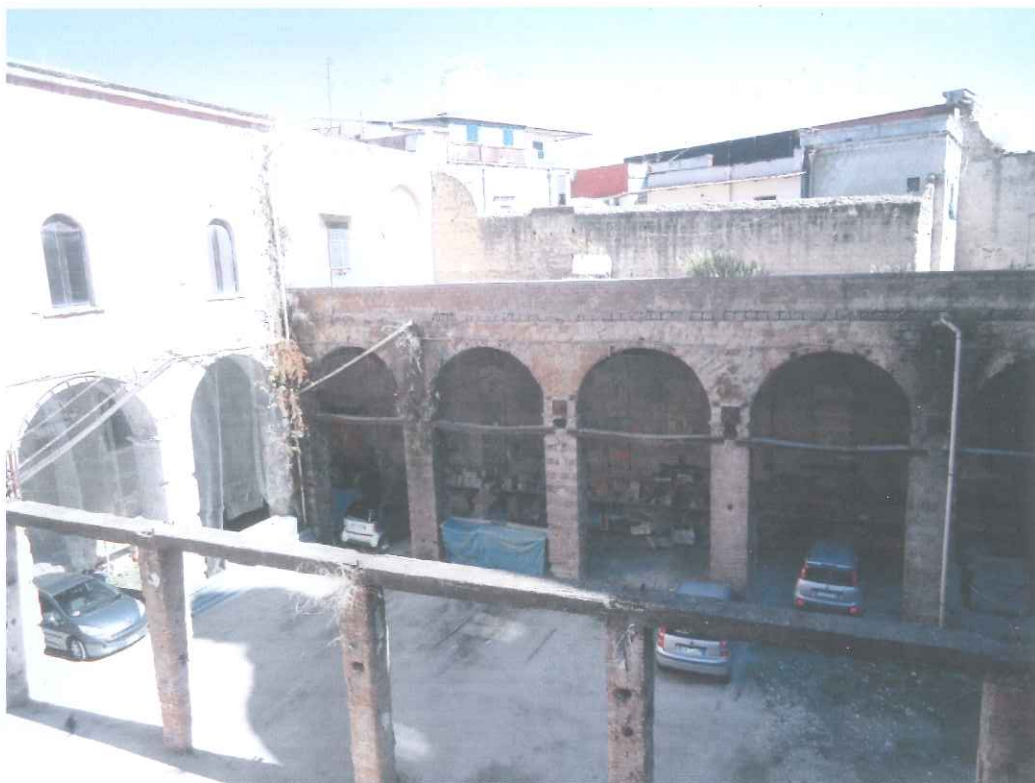
Foto n°11 - Il cortile principale dal piano nobile. In primo piano il colonnato e il cordolo sovrastante realizzati per sostenere la copertura del cortile oggi non più esistente
