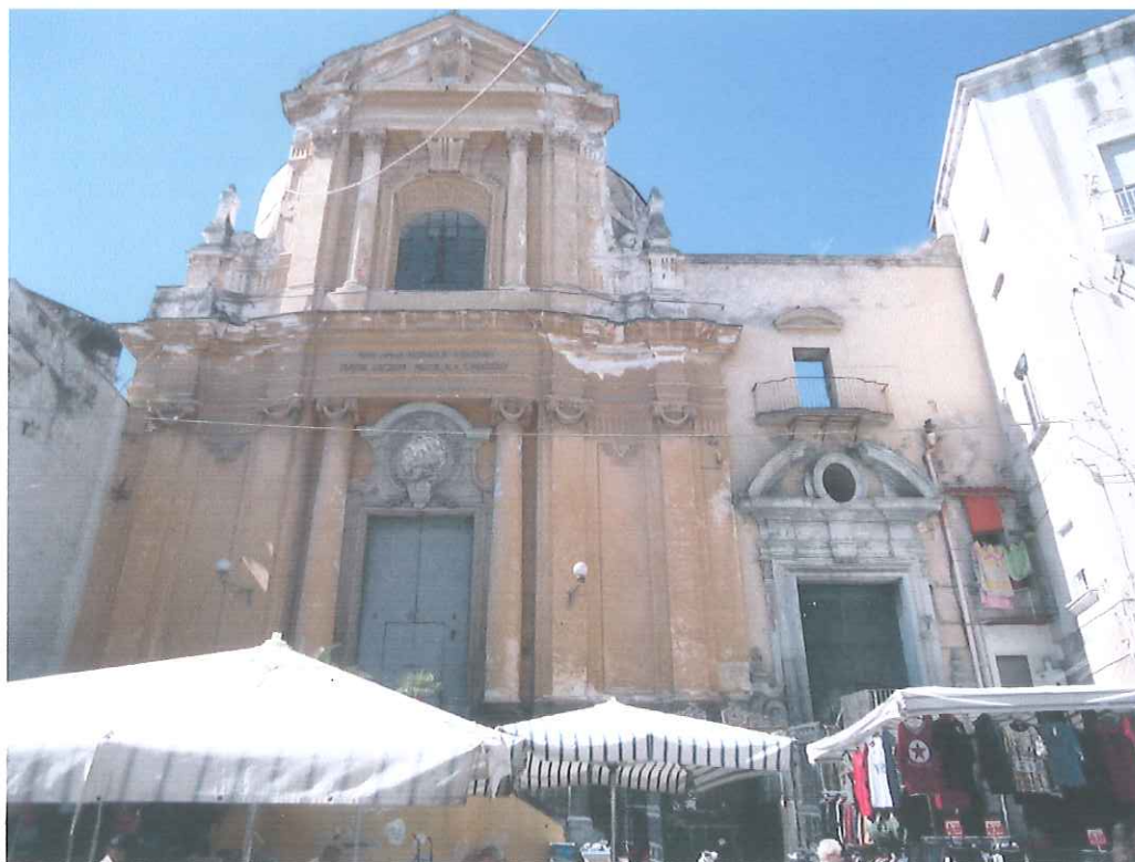
Foto n°16 - La facciata della chiesa di S. Anna a Capuana e, accanto, la facciata e l'ingresso all'immobile da piazza S. Anna a Capuana
