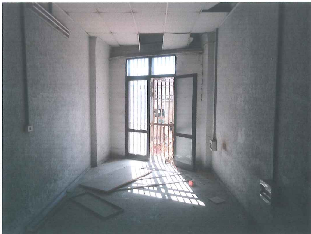
Foto n°24 - Particolare del corridoio del primo piano con affaccio su via Cesare Rosaroll
