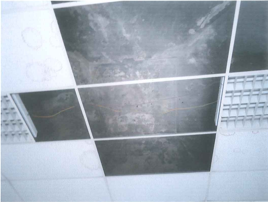
Foto n°27 - il soffitto a volta di uno dei vani del primo piano
