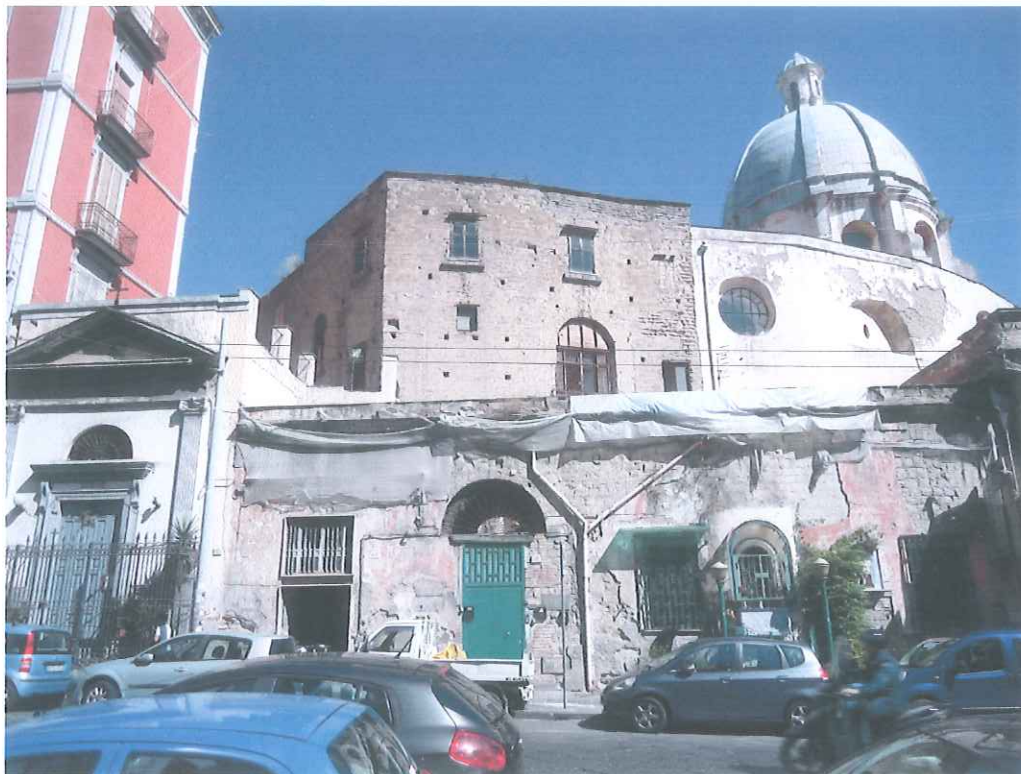
Foto n°15 - Vista dei piani superiori del corpo A da via Cesare Rosaroll
