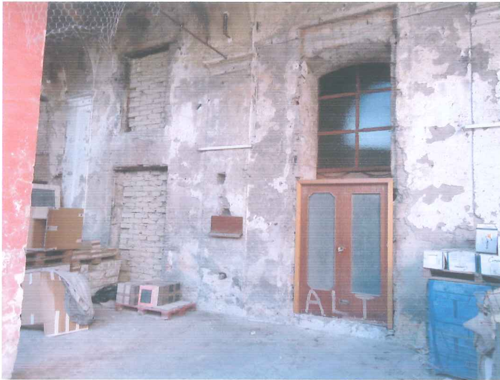
Foto n°9 - Particolare dei locali al piano terra del corpo A
